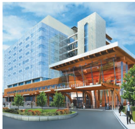
Hôpital de Surrey, en Colombie-Britannique, construction selon les normes LEED «Or» et privilégiant l'utilisation du bois, conformément à la Wood First Act de la Colombie-Britannique.
