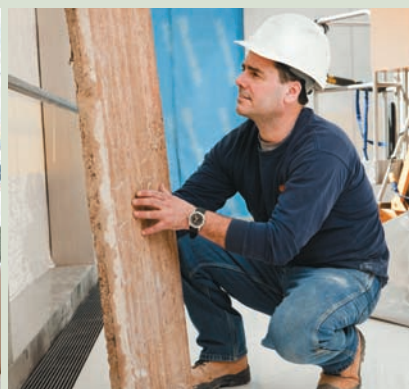
Récupération des travertins du plancher de l'ancien hall
